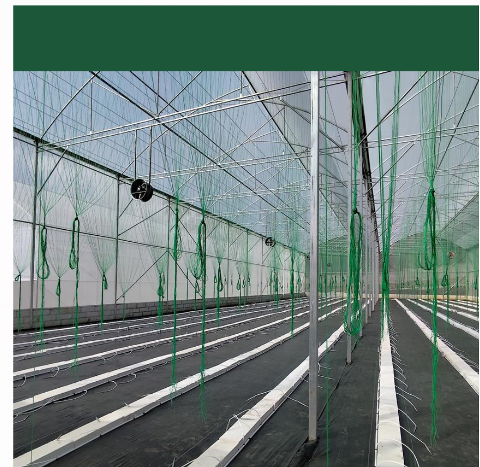
Finishing lantai dengan weedmat hitam 100 Gsm
